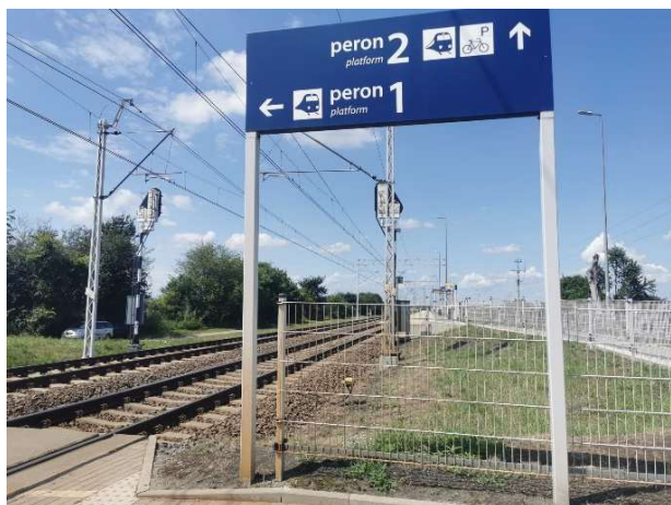
Rys. 38. Przystanek kolejowy w obrębie Końskowola Źródło: Inwentaryzacja terenowa
