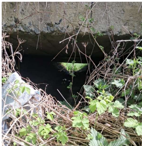
Rys. 62. Przepust znajdujące się we Wronowie Źródło: Inwentaryzacja terenowa
