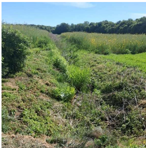
Rys. 61. . Rów melioracyjny wymagający prac w Nowym Pożogu Źródło: Inwentaryzacja terenowa
