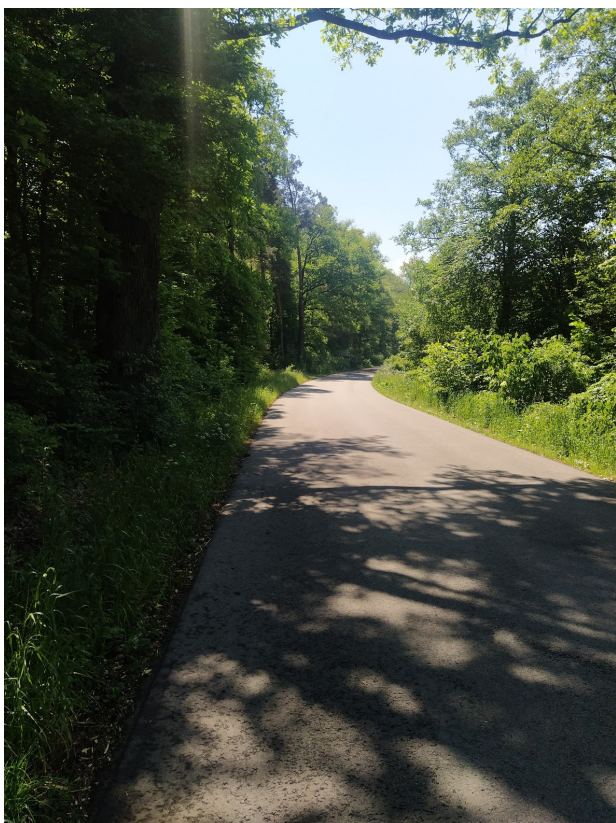
Rys. nr 34 Droga powiatowa w Nosowie
