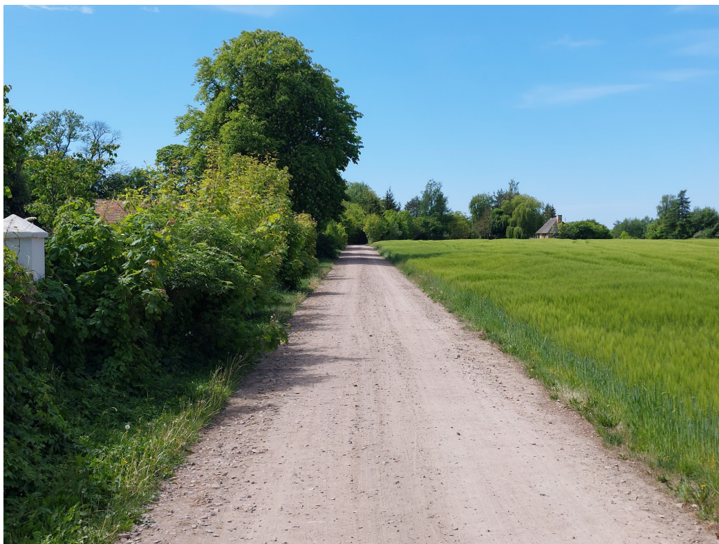
Rys. nr 36 Droga gminna w Nosowie
