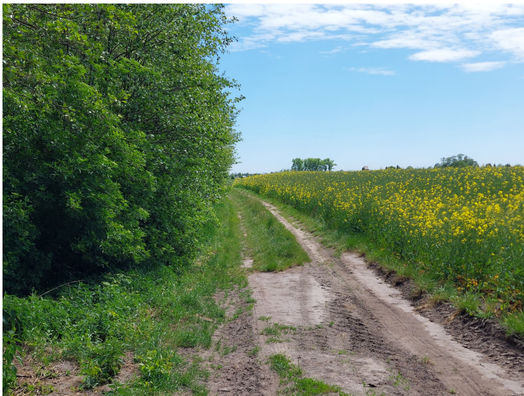
Rys. nr 37 Droga gminna w Nosowie
