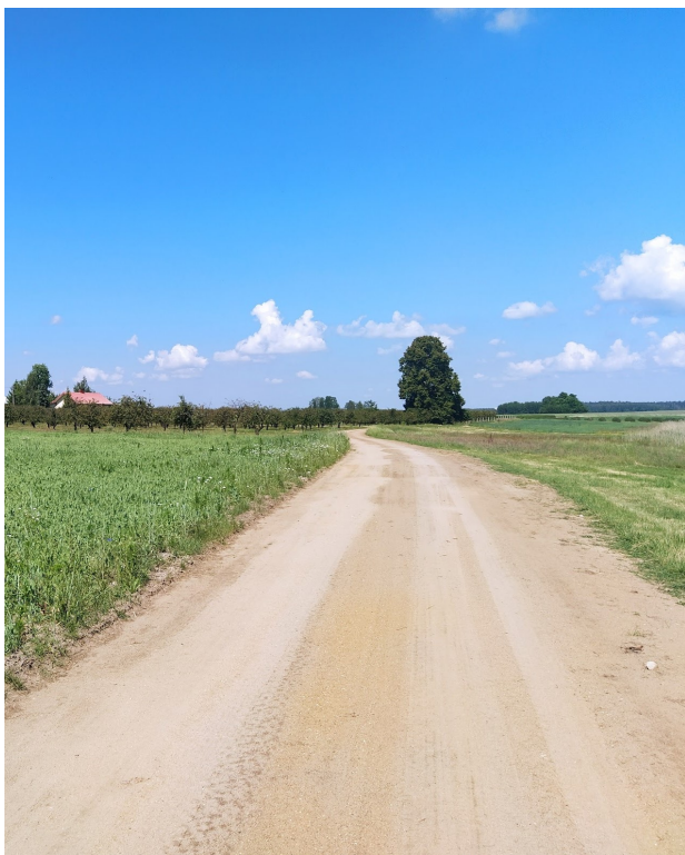
Rys. nr 33 Droga gminna w Nosowie
