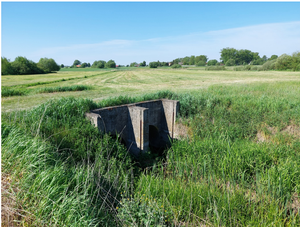
Rys. nr 29 Zapora w Bukowicach
