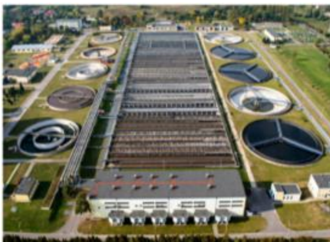
Fot. 23 Oczyszczalnia Ścieków „Hajdów” położona we wschodniej części miasta Lublina
