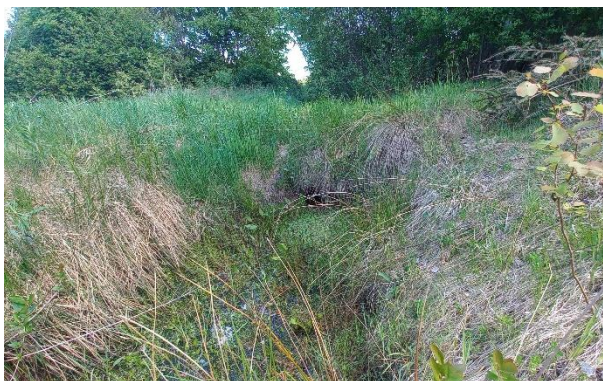
Rys. 37 Zdjęcia przepustów w gminie Frampol
